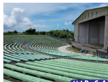
野外劇場 ※新屋外劇場建設中
